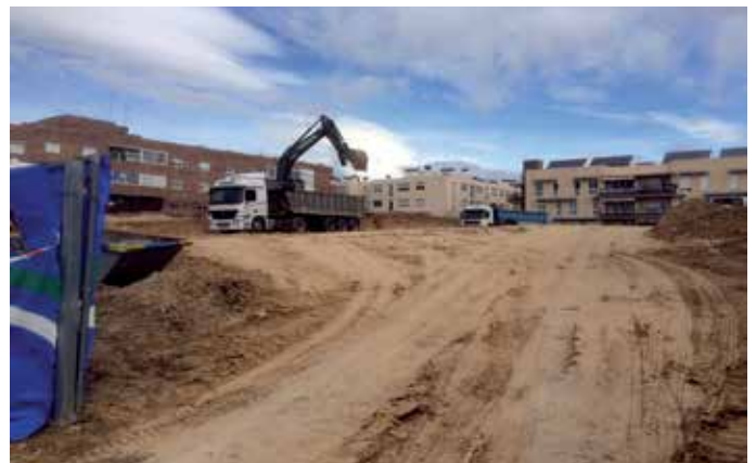
Imagen de las obras.
